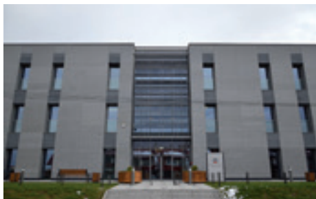
Wejście główne do budynku
