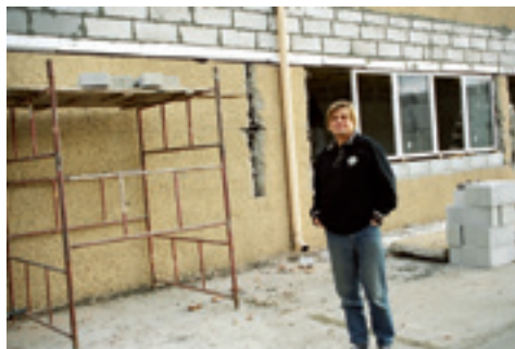
Budowa Pracowni Konserwacji Masowej w Gdyni
