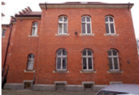
Skrzydło zabytkowe APG po remoncie
