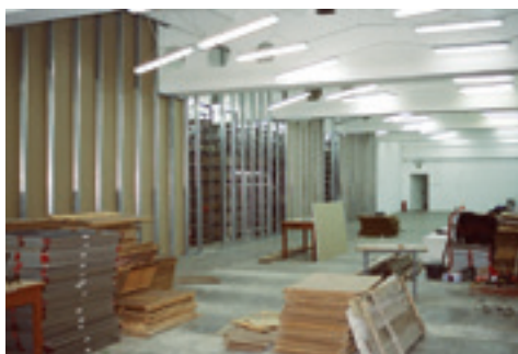
Przebudowa starego magazynu na Pracownię Konserwacji Masowej
